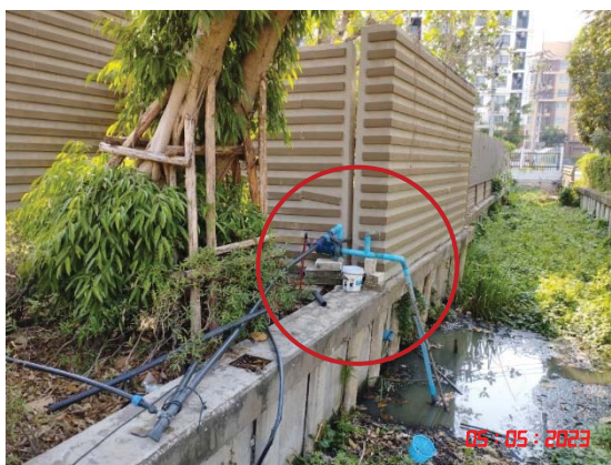
รูปที่ 8 ท่อสูบน้ำทิ้งที่ผ่านระบบบำบัดน้ำเสีย
