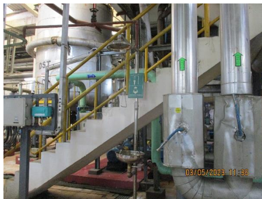
รูปที่ 25 การติดตั้งฝักบัวอาบน้ำและที่ล้างตาฉุกเฉิน
