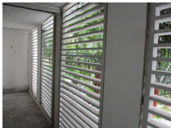
รูปที่ 4 ช่องเปิดระบายอากาศของโครงการ
