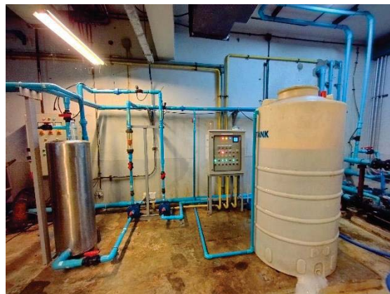
รูปที่ 7 ระบบบำบัดน้ำเสียเบื้องต้น
