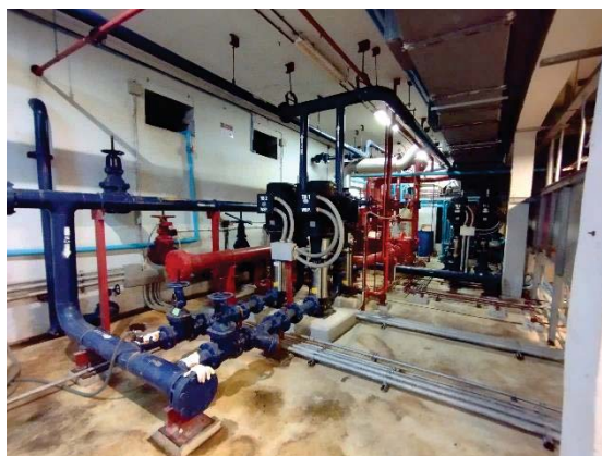
รูปที่ 9 ระบบจ่ายน้ำภายในโครงการ
