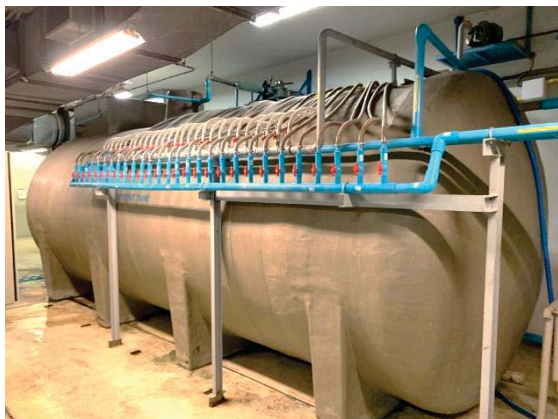
รูปที่ 7 ระบบบำบัดน้ำเสียเบื้องต้น
