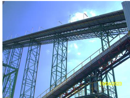
รูปที่ 15 ระบบสายพานลำเลียงเชื้อเพลิงจากอาคารป้อนเชื้อเพลิงไปยังหม้อไอน้ำ (ระบบปิดครอบ)
