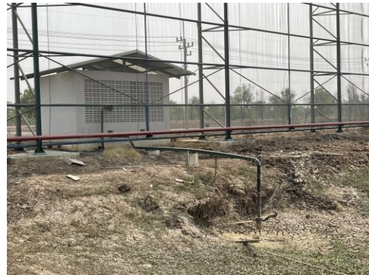
รูปที่ 19 ระบบรวบรวมน้ำชะลานกองเถ้า
