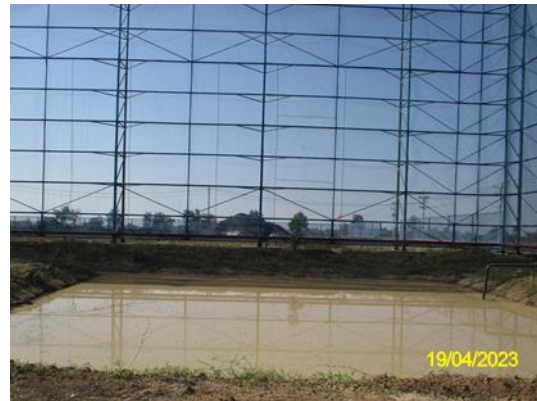
รูปที่ 6 ระบบรวบรวมน้ำชะลานกองเชื้อเพลิง
