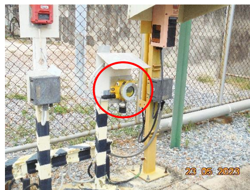
รูปที่ 2.1-3 ติดตั้งเครื่องตรวจจับก๊าซ (Gas Detector) บริเวณสถานีสูบน้ำทางรถบรรทุก
