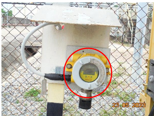
รูปที่ 2.1-3 ติดตั้งเครื่องตรวจจับก๊าซ (Gas Detector) บริเวณสถานีสูบน้ำทางรถบรรทุก
