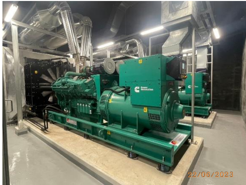
รูปที่ 31 เครื่องกำเนิดไฟฟ้าฉุกเฉิน
