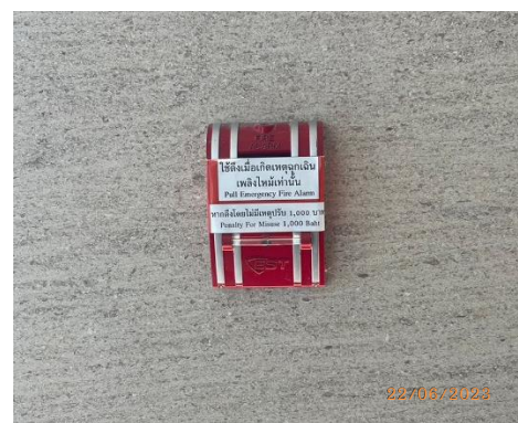
รูปที่ 41 เครื่องแจ้งเหตุโดยใช้มือดึง (Manual Pull Station)
