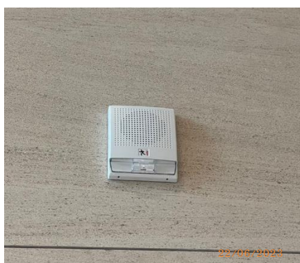
รูปที่ 40 ลำโพงแจ้งสัญญาณเตือนภัย (Fire Alarm Speaker)
