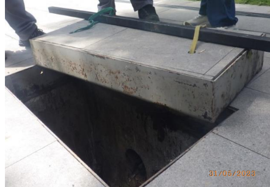
รูปที่ 19 บ่อตรวจคุณภาพน้ำพร้อมตะแกรงดักขยะ
