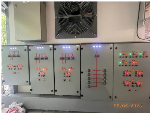
รูปที่ 20 ระบบมอเตอร์ไฟฟ้าสำหรับระบบบำบัดน้ำเสีย
