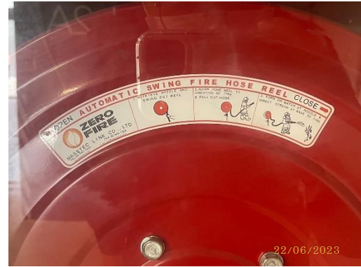
รูปที่ 47 ตู้เก็บสายฉีดน้ำดับเพลิง และป้ายแนะนำการใช้อุปกรณ์
