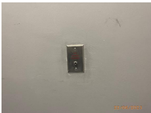
รูปที่ 45 โทรศัพท์แจ้งเหตุเพลิงไหม้ (Fire Man Telephone Outlet)
