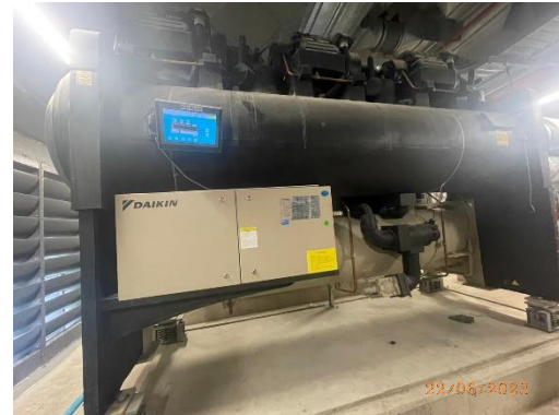
รูปที่ 32 ติดตั้งระบบчилเลอร์ เพื่อประหยัดพลังงาน
