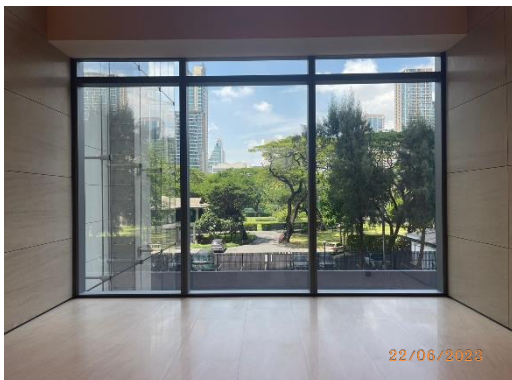
รูปที่ 50 อาคารโครงการด้านที่ติดกับบ้านพักอาศัย เอกอัครราชทูตสหรัฐอเมริกา ผนังอาคารเป็นกระจกไม่ สามารถเปิดออกภายนอกได้ และไม่มีระเบียง
