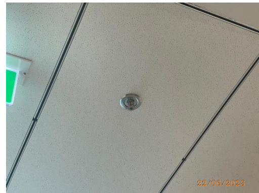
รูปที่ 39 หัวฉีดน้ำอัตโนมัติ
