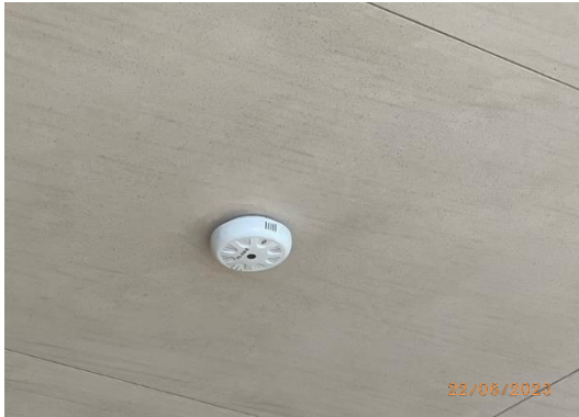
รูปที่ 42 เครื่องตรวจจับความร้อน (Heat Detector)
