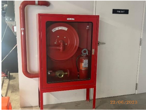
รูปที่ 47 ตู้เก็บสายฉีดน้ำดับเพลิง และป้ายแนะนำการใช้อุปกรณ์
