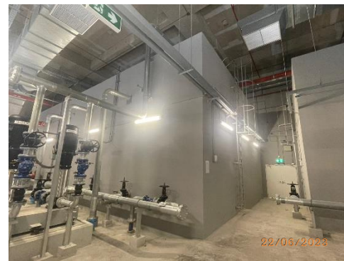
รูปที่ 34 ถังเก็บน้ำสำรอง
