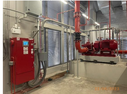
รูปที่ 37 เครื่องสูบน้ำดับเพลิง (Fire pump)
