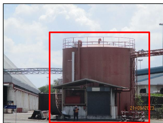
รูปที่ 2-8 ถังเก็บกากน้ำ
