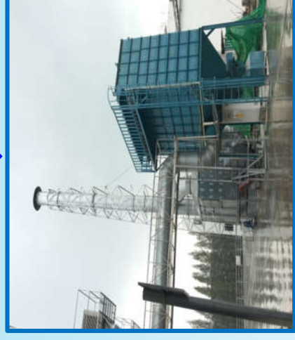
ระบบดักฝุ่นแบบถุงกรองและ เครื่องบำบัดอากาศแบบสครับเบอร์
