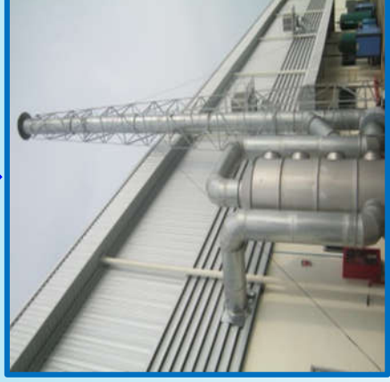
เครื่องบำบัดอากาศแบบสครับเบอร์
