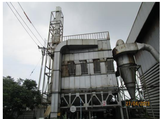
รูปที่ 3 ระบบดักฝุ่นแบบถุงกรอง
