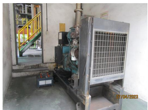
รูปที่ 12 ระบบไฟฟ้าสำรองชนิดใช้น้ำมันดีเซล
