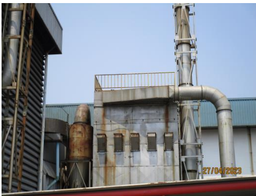
รูปที่ 3 ระบบดักฝุ่นแบบถุงกรอง
