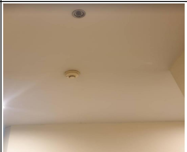
ภาพที่ 31 Smoke Detector
