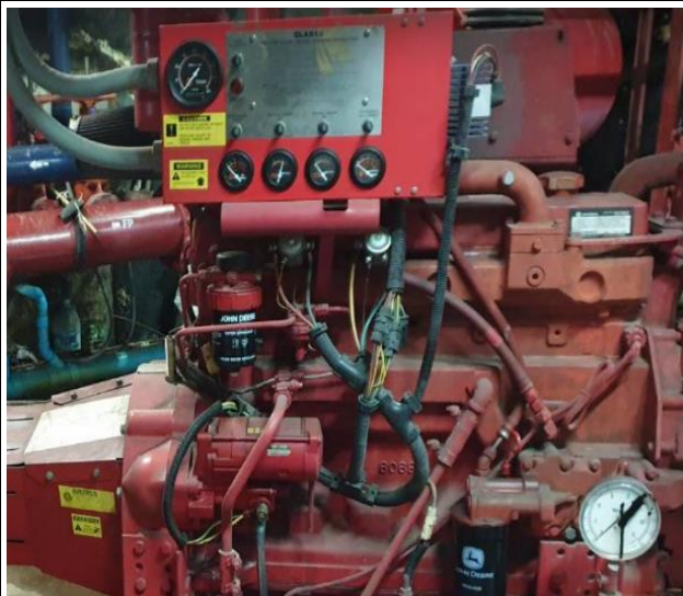
ภาพที่ 26 เครื่องสูบน้ำดับเพลิง
