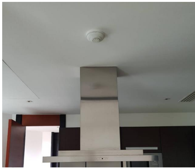
ภาพที่ 32 Heat Detector
