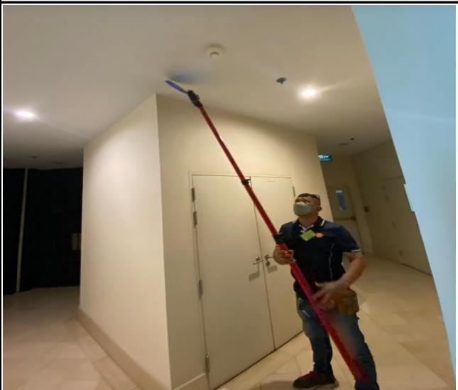
ภาพที่ 36 ตรวจสอบระบบ Fire Alarm โดยบริษัท ดียะ มาสเตอร์ ปีละ 3 ครั้ง
