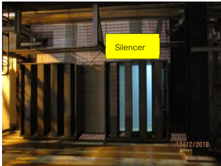
รูปที่ ค-7 ติดตั้งอุปกรณ์ลดเสียง (Silencer) บริเวณ Steam Turbine Enclosure โรงไฟฟ้าบางปะกง ชุดที่ 5
