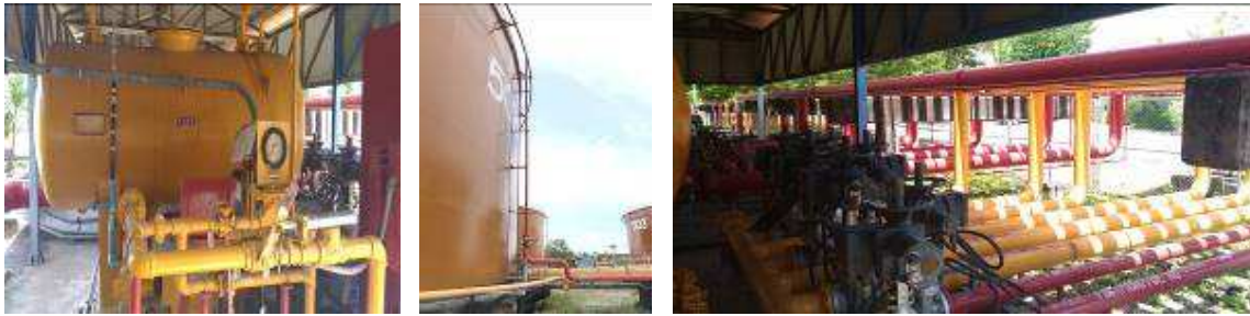
รูปที่ ค-52 ระบบโฟมอยู่บริเวณตรงข้ามกับอาคารทำการนายท่า โดยจะมีท่อโฟมส่งไปถึงเก็บน้ำมันทุกถัง
