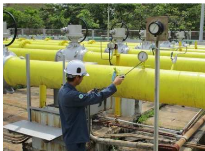
รูปที่ ค-36 การตรวจสอบการรั่วไหลของก๊าซธรรมชาติ
