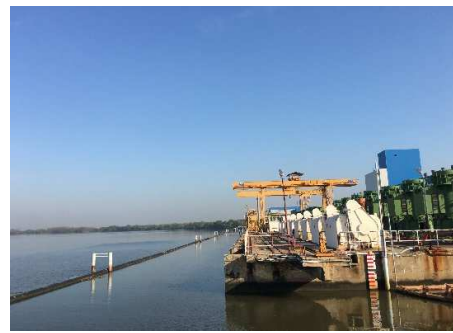
รูปที่ ค-22 ฟันลอยดักขยะบริเวณหน้าอาคารสูบน้ำเข้าระบบหล่อเย็นของโรงไฟฟ้า
