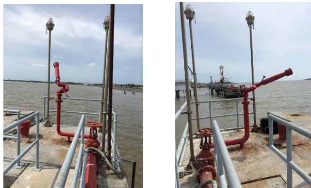
รูปที่ ค-45 เครื่องฉีดน้ำแบบตั้งอยู่กับที่
