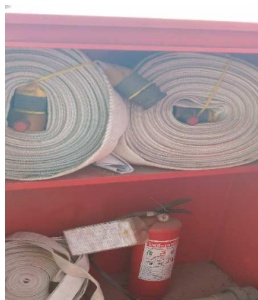
รูปที่ ค-48 ถังดับเพลิงแบบมือถือชนิด ABC Chemical อยู่ภายในตู้เก็บบริเวณปลายท่า
