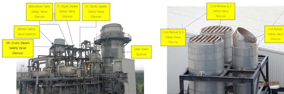
รูปที่ ค-6 ติดตั้งอุปกรณ์ลดเสียง (Silencer) บริเวณ HRSG โรงไฟฟ้าบางปะกง ชุดที่ 5 และบริเวณกังหันไอน้ำโรงไฟฟ้าบางปะกง ชุดที่ 5
