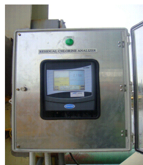
รูปที่ ค-20 การตรวจวัดอุณหภูมิและค่าคลอรีน อัตโนมัติของโรงไฟฟ้าบางปะกง
