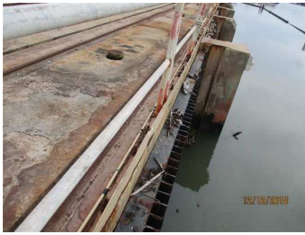
รูปที่ ค-21 เครื่องเก็บขยะบริเวณตะแกรงหน้าอาคารสูบน้ำเข้าระบบหล่อเย็นของโรงไฟฟ้า
