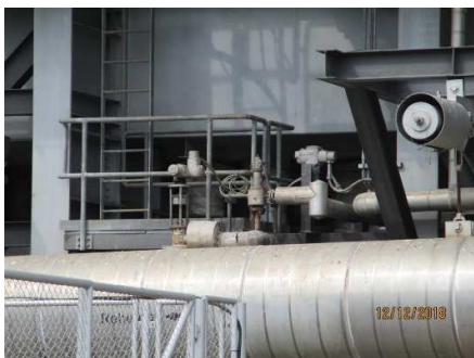
รูปที่ ค-39 Relief Valve
