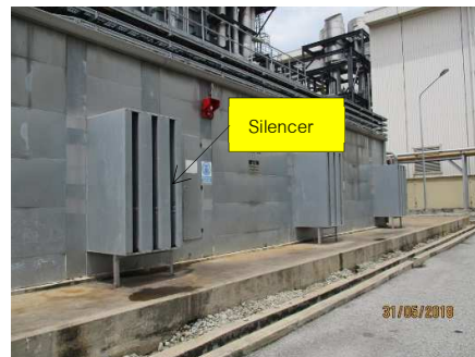
รูปที่ ค-10 ติดตั้งอุปกรณ์ลดเสียง (Silencer) บริเวณ Feed Water Pump
