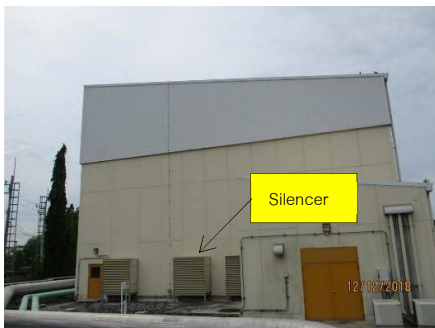
รูปที่ ค-9 ติดตั้งอุปกรณ์ลดเสียง (Silencer) บริเวณ อาคารคลุม Fuel Gas Compressor
