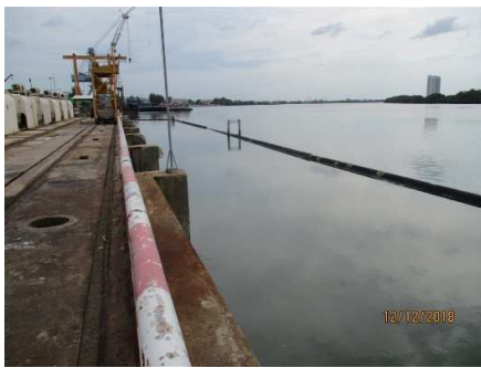
รูปที่ ค-22 ฟันลอยดักขยะบริเวณหน้าอาคารสูบน้ำเข้าระบบหล่อเย็นของโรงไฟฟ้า
