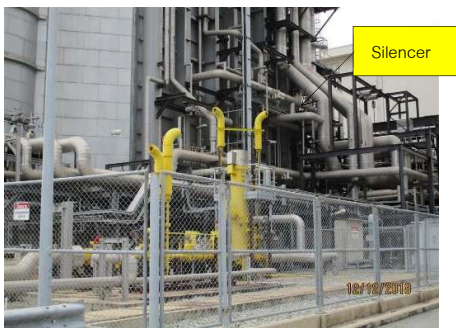
รูปที่ ค-11 ติดตั้งอุปกรณ์ลดเสียง (Silencer)
