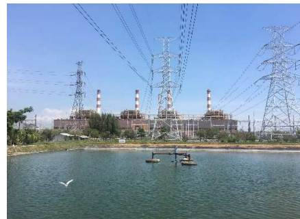
ระบบบำบัดน้ำเสียแบบ Aerated Lagoon
