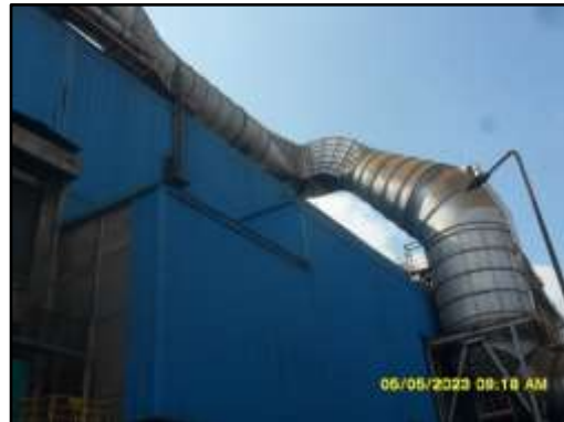
ภาพที่ 2.2 ระบบดูดฝุ่นแบบ Canopy Hood
