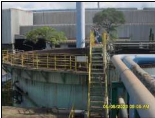
ภาพที่ 2.18 บ่อตกตะกอน (Clarifier)
