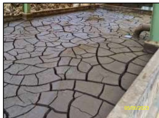
ภาพที่ 2.9 บ่อตากตะกอน (Sludge Drying Bed)
