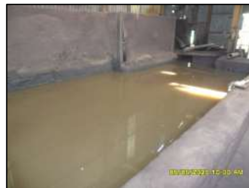
ภาพที่ 2.19 บ่อดักแยกคราบไขมันออกจากน้ำหมุนเวียน
