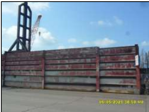
ภาพที่ 2.6 ลานคอนกรีตที่มีผนังกันเป็นช่อง สำหรับกองเก็บวัตถุดิบก่อนเข้าสู่เตาหลอม
