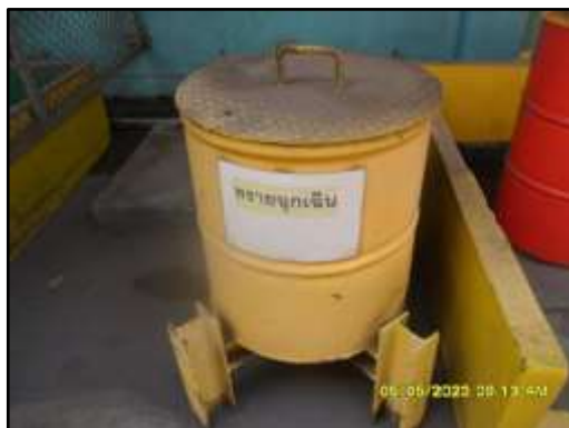
ภาพที่ 2.14 ถังทรายที่ใช้ดูดซับสารเคมีภายในโครงการ กรณีสารเคมีหกหรือรั่วไหล
