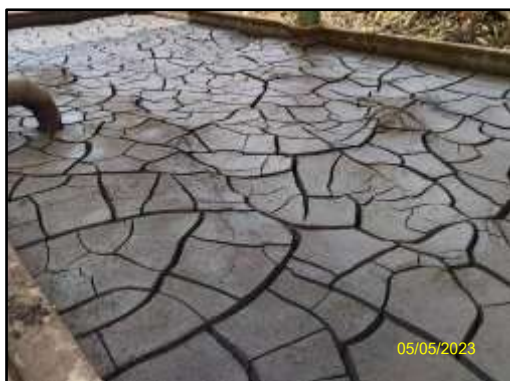
ภาพที่ 2.9 บ่อตากตะกอน (Sludge Drying Bed)
