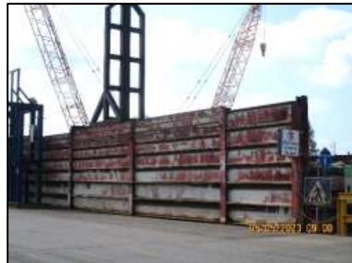
ภาพที่ 2.6 ลานคอนกรีตที่มีผนังกันเป็นช่อง สำหรับกองเก็บวัตถุดิบก่อนเข้าสู่เตาหลอม
