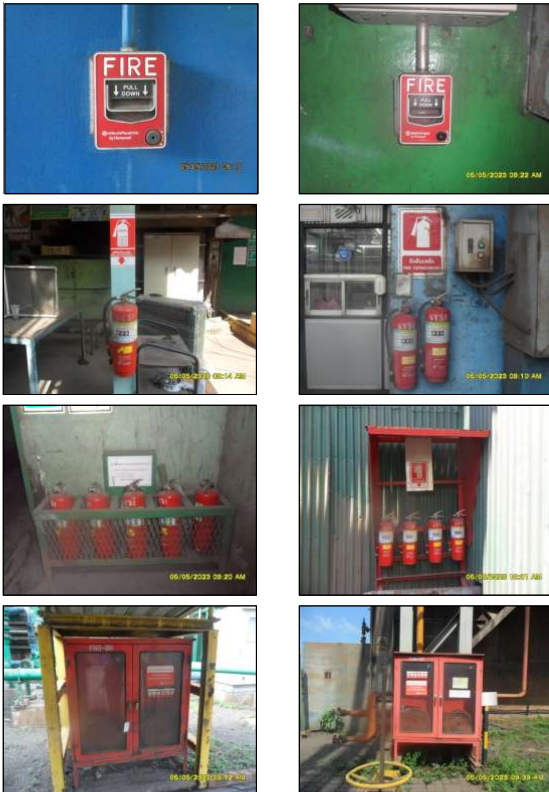
ภาพที่ 2.29 ระบบดับเพลิงภายในโครงการ
