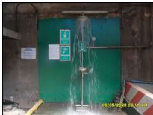
ภาพที่ 2.33 ฝักบัวฉุกเฉินภายในพื้นที่โครงการ
