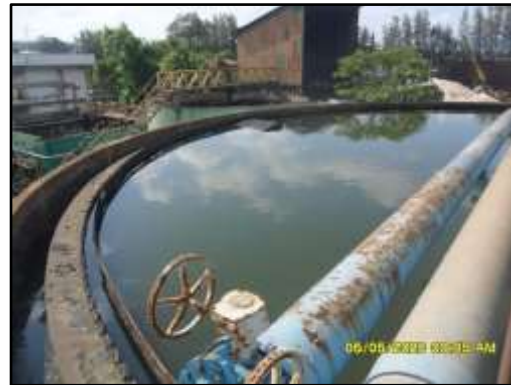
ภาพที่ 2.18 บ่อตกตะกอน (Clarifier)
