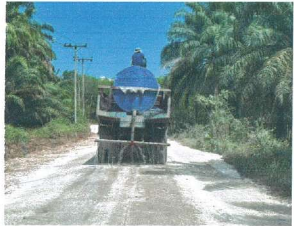
รูปที่ 2 ใช้รถน้ำถาดน้ำเส้นทางลำเลียงและติดตั้งระบบสเปย์น้ำทางเข้า-ออกเหมือง
