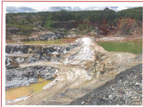
รูปที่ 4 บ่อดักตะกอนดินรองรับน้ำจากกระบวนการชะล้างแร่และน้ำจากชุมชนเหมือง
