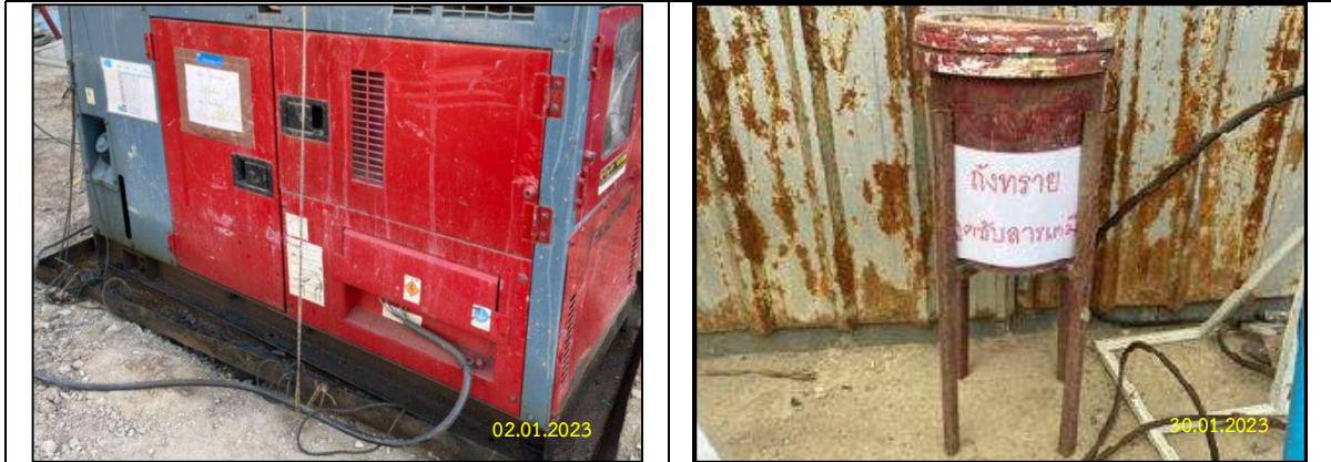
รูปที่ 2-14 การจัดเตรียมภาคเก็บรองรับน้ำมัน และวัสดุดูดซับ
