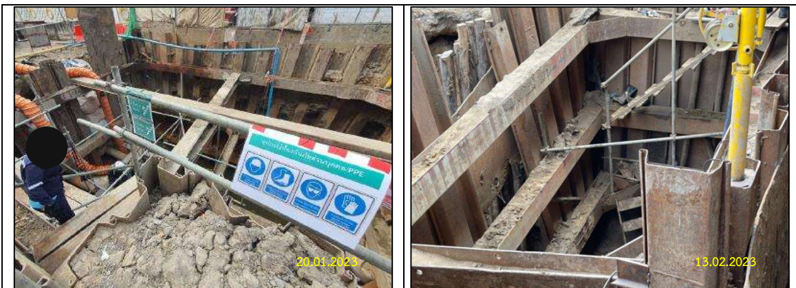
รูปที่ 2-10 การติดตั้ง Sheet Pile เพื่อป้องกันการพังทลายของดิน
