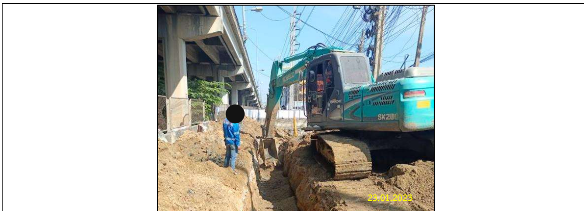
ก) การขุดด้วยเครื่องจักร ที่ไม่มีผู้ปฏิบัติงานในร่องขุด/บ่อรับ-บ่อส่ง
