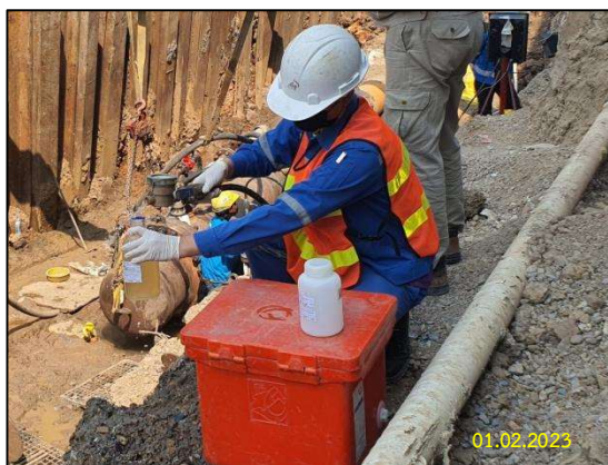
รูปที่ 3-4 การติดตามตรวจสอบคุณภาพน้ำทิ้งจากกิจกรรมการทดสอบท่อด้วยวิธีทางชลสถิต
