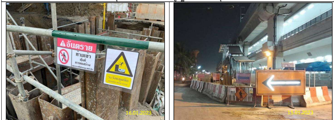
ข) อุปกรณ์ป้องกันการตกหลุมบริเวณปากหลุมร่องขุด/บ่อรับ-บ่อส่ง และมีแสงสว่างเพียงพอและไฟกระพริบในเวลากลางคืน
