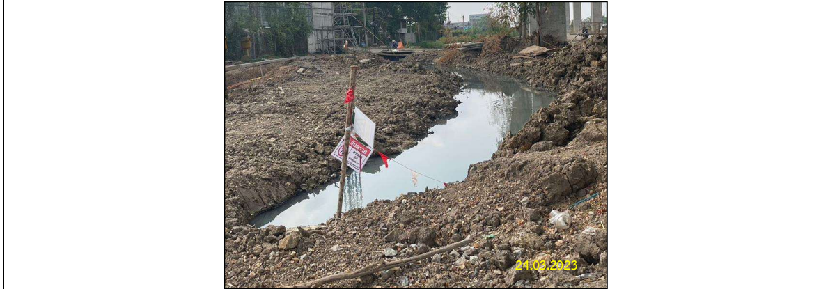
รูปที่ 2-17 การทำทางเบี่ยงเบนทิศทางการไหลของน้ำชั่วคราว
