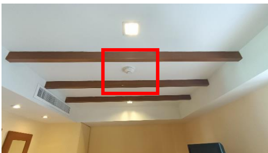
ภาพที่ 49 เครื่องดับจับควันในห้องพัก
