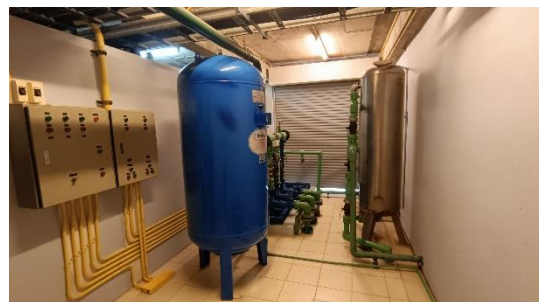
ภาพที่ 20 ระบบถังกรองน้ำใช้
