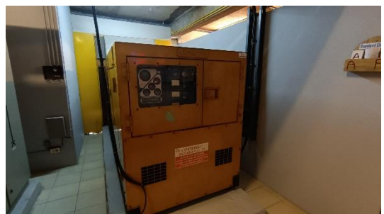
ภาพที่ 48 เครื่องผลิตไฟฟ้าสำรอง
