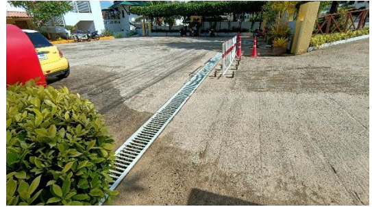
ภาพที่ 22 ตะแกรงดักขยะ
