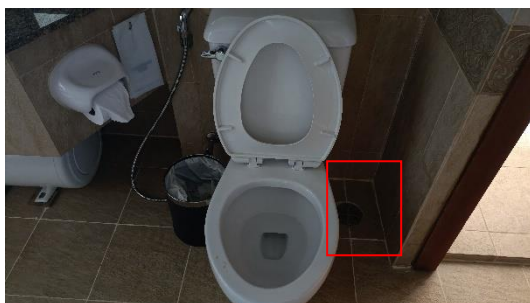
ภาพที่ 55 ตะแกรงครอบตามรูท่อระบายน้ำทั้งภายใน อาคาร
