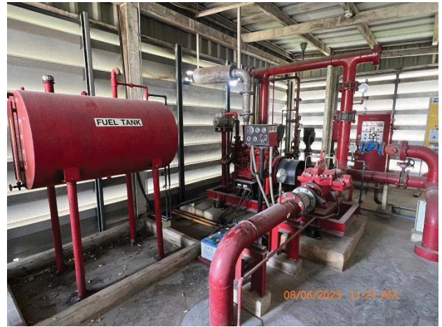
ภาพที่ 50 ชุดเครื่องสูบน้ำดับเพลิง
