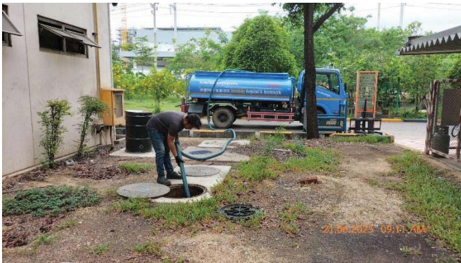
ภาพที่ 21 การดูแลทำความสะอาดถังบำบัดน้ำเสียสำเร็จรูป
