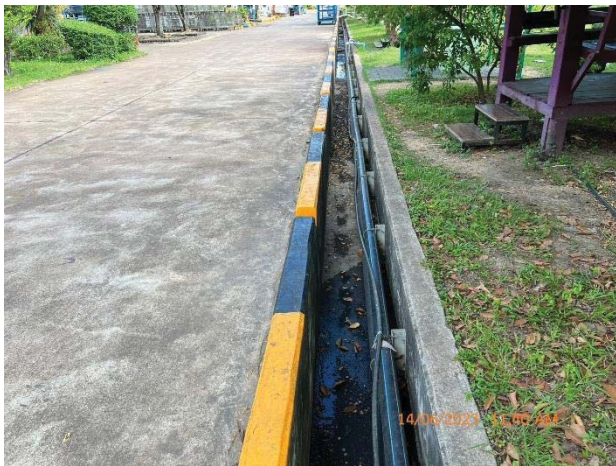
ภาพที่ 17 ระบบระบายน้ำเสียแยกออกจากรางระบายน้ำฝน
