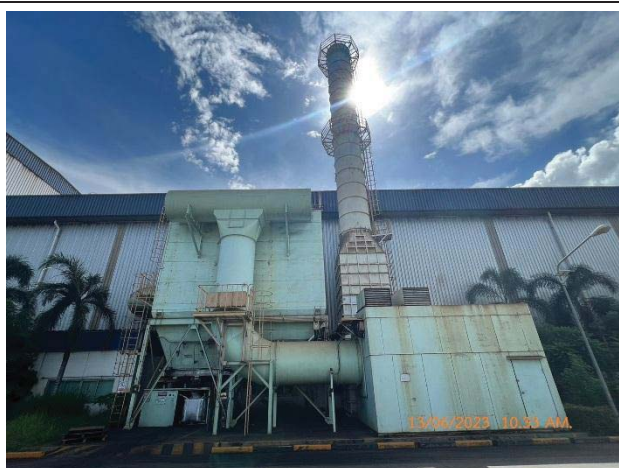
ภาพที่ 3 ปล่องระบบดักฝุ่นจากขั้นตอน Molding line (BH3)
