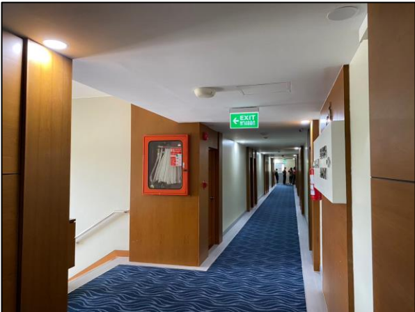
ถังดับเพลิงและตู้เก็บสายฉีดน้ำดับเพลิงภายในอาคาร
