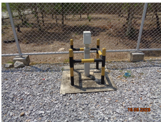
รูปที่ 3-10 ระบบจ่ายกระแสไฟฟ้า Rectifier
