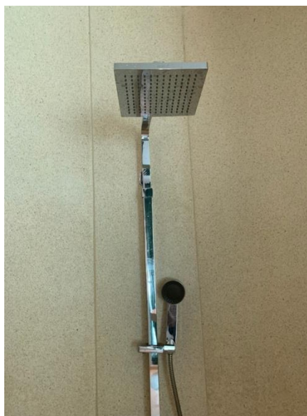
ภาพที่ 6 ฝักบัวรุ่นประหยัดน้ำภายในห้องพักแขก
