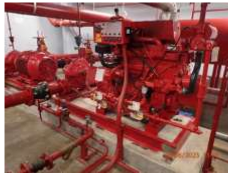
รูปที่ 1.8-1 เครื่องสูบน้ำดับเพลิง (Fire Pump)
