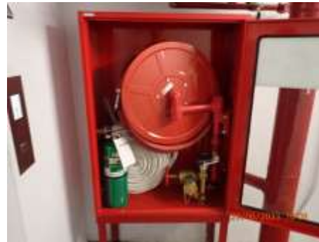
รูปที่ 1.8-2 ระบบท่อขึ้น (Stand Pipe)
