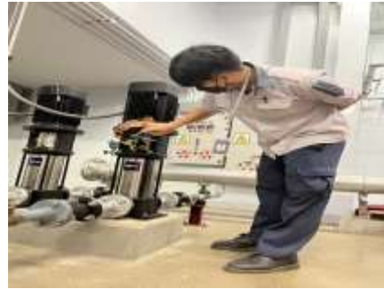
ภาพที่ 2.2-11 ตรวจสอบและบำรุงรักษาปั๊มสูบน้ำประปา
