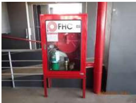
รูปที่ 1.8-2 ระบบท่อขึ้น (Stand Pipe)
