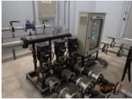
ภาพที่ 2.2-10 ระบบปั๊มสูบน้ำประปา
