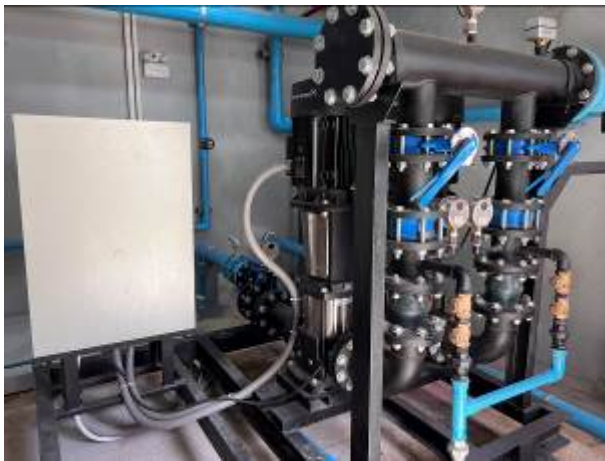
ภาพที่ 1-4 เครื่องสูบน้ำจ่ายน้ำไปยังส่วนต่างๆ ภายในโครงการ
