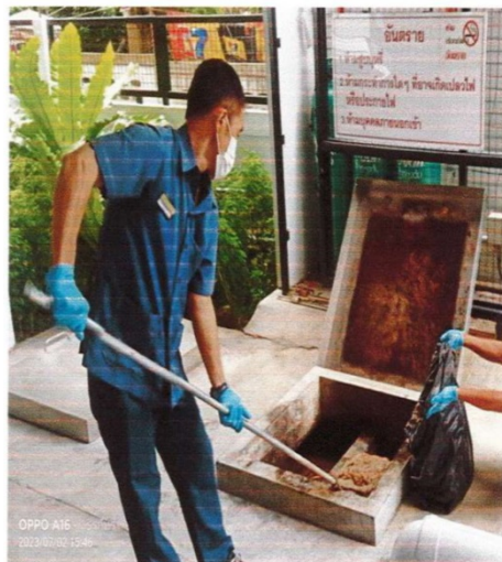
ภาพที่ 1-8 เจ้าหน้าที่ดักไขมัน และมิเตอร์ไฟฟ้าสำหรับระบบบำบัดน้ำเสีย
