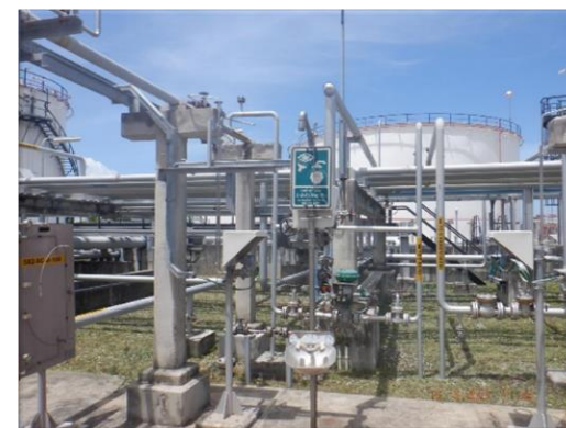
รูปที่ 2-28 ฝักบัวอาบน้ำล้างตาฉุกเฉิน
