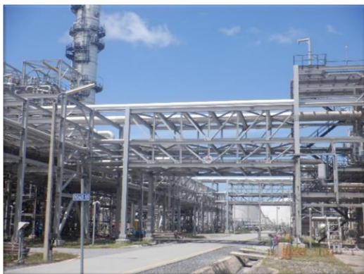
รูปที่ 2-39 การวางท่อนบน Pipe Rack หรือ Pipe Bridge ในลักษณะที่ปลอดภัย
