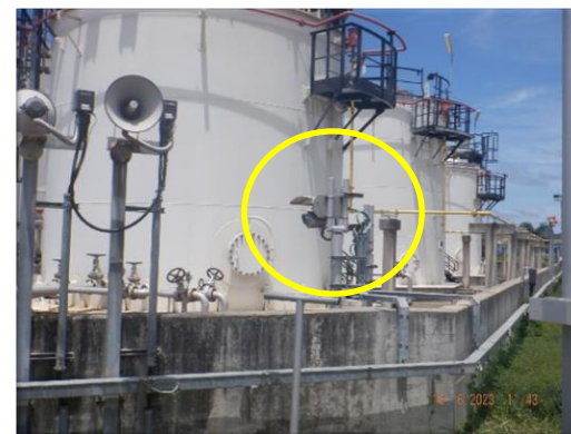
รูปที่ 2-30 ระบบตรวจจับก๊าซพิษในพื้นที่กระบวนการผลิต
