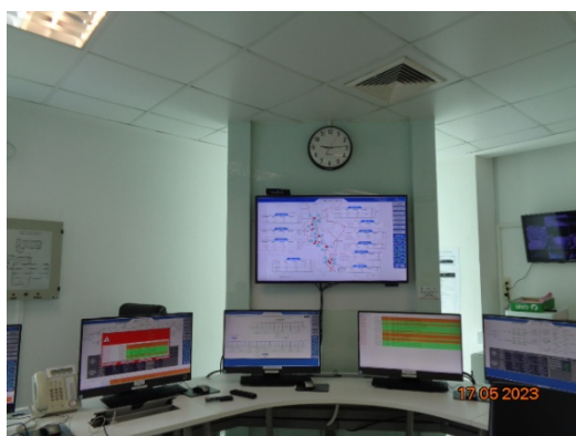
รูปที่ 3-2 ศูนย์ควบคุมฉุกเฉิน (SCADA ROOM)
