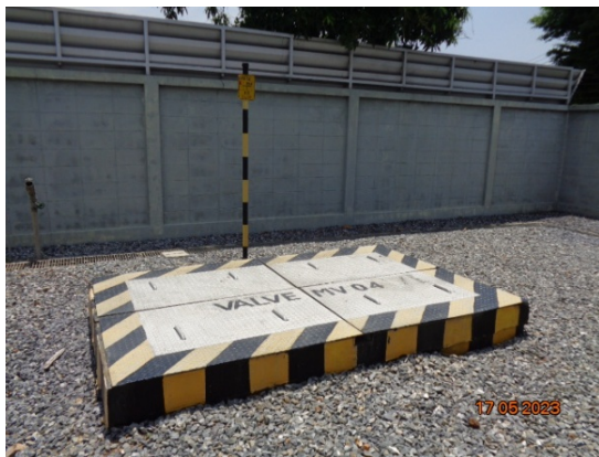
รูปที่ 3-8 ระบบวาล์วใต้ดินเพื่อสามารถตัดแยกระบบกรณีเกิดเหตุฉุกเฉิน
