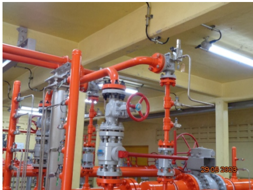
รูปที่ 3-6 วาล์วควบคุมแรงดันเกินชั่วคราว (Pressure Relieve Valve) บริเวณสถานีก๊าซฯ OTS
