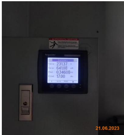
รูปที่ 2-13 ติดตั้งมาตรวัดไฟฟ้าในส่วนของระบบบำบัดน้ำเสีย แยกออกจากส่วนอื่นๆ
