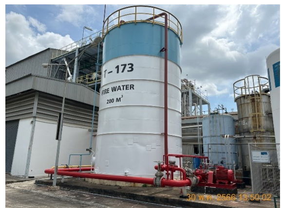
รูปถ่ายที่ 3.2-38 : ถังเก็บสำรองน้ำดับเพลิง ขนาด 200 ลูกบาศก์เมตร
