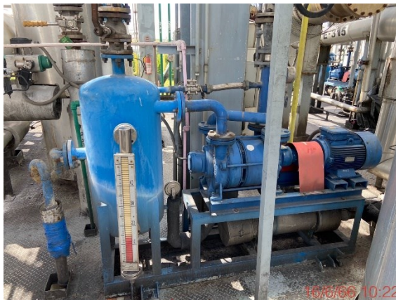
รูปถ่ายที่ 3.2-3 : Vacuum pump สำหรับดูดฝุ่นของ AA
