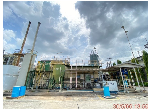
รูปถ่ายที่ 3.2-8 : ระบบบำบัดน้ำเสียแบบตะกอนเร่ง (Activated Sludge: AS)
