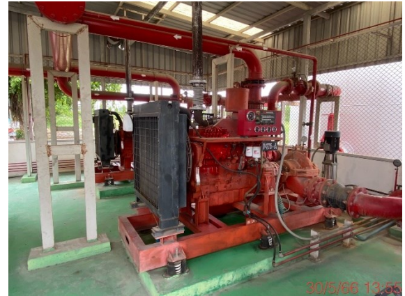
รูปถ่ายที่ 3.2-29 : ระบบดับเพลิงแบบดีเซล
