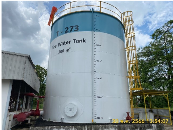
รูปถ่ายที่ 3.2-39 : ถังเก็บสำรองน้ำดับเพลิง ขนาด 300 ลูกบาศก์เมตร
