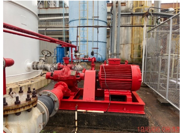
รูปถ่ายที่ 3.2-40 : ปั๊มน้ำดับเพลิงแบบไฟฟ้าขนาด 180 ลูกบาศก์เมตร/ชั่วโมง
