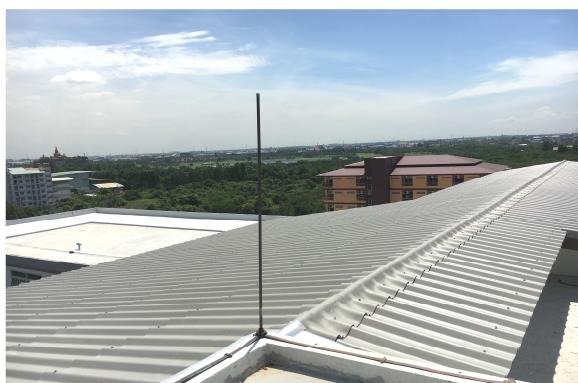
ภาพที่ 2-13 เสาหล่อฟ้า
