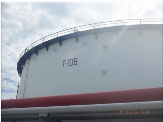
รูปที่ 2-8 ถัง Slop สำหรับกลับมาใช้ โดยผสมในหน่วยกลั่นน้ำมันดิบ
