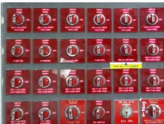
รูปที่ 2-33 ระบบหยุดสูบล้างฉุกเฉินทั้งระบบ บริเวณห้องควบคุม
