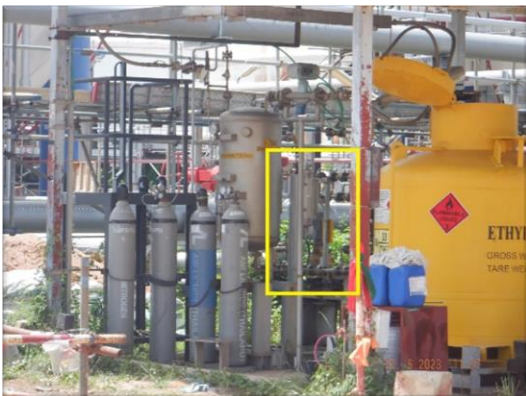
รูปที่ 2-35 Lock-out Mercaptan Injection Pump
