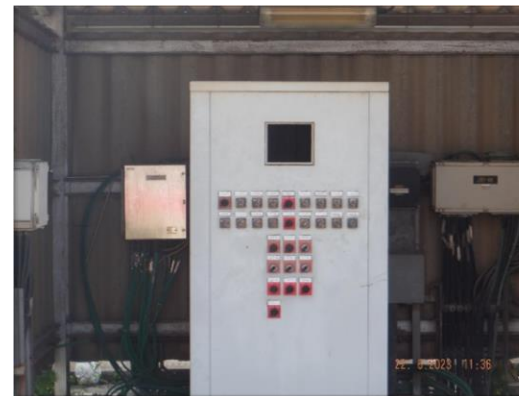
รูปที่ 2-32 ระบบหยุดสูบล้างฉุกเฉินทั้งระบบ บริเวณถังจัดเก็บ
