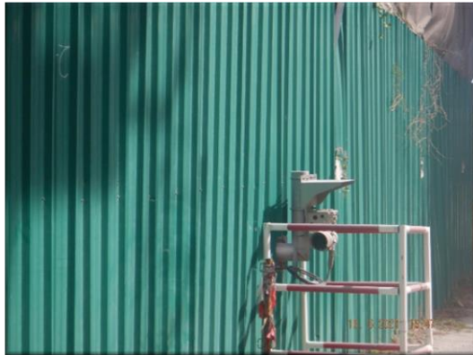
รูปที่ 2-23 อุปกรณ์ตรวจสอบการไหม้ไฟรั่วระยะเหวแบบลำแสง
