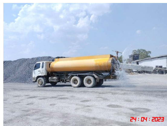
รูปที่ 9 การฉีดพรมน้ำในพื้นที่โครงการ
