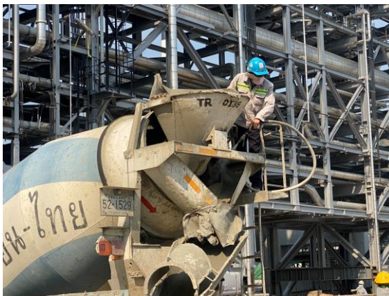
รูปที่ 2-9 การทำความสะอาดรางระบายคอนกรีตของรถขนคอนกรีต
