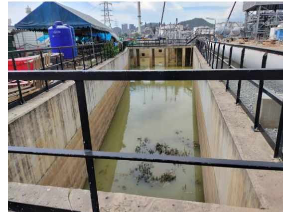
รูปที่ 2-11 ระบบระบายน้ำในพื้นที่ก่อสร้างและเชื่อมต่อกับบ่อรวบรวม
