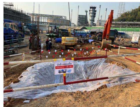
รูปที่ 2-10 บ่อล้างและรวบรวมตะกอนคอนกรีต
