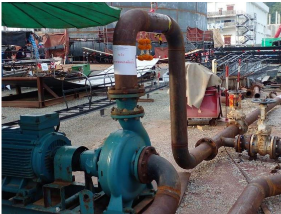
รูปที่ 2-16 การทดสอบแรงดันของท่อ (Hydrostatic Test)
