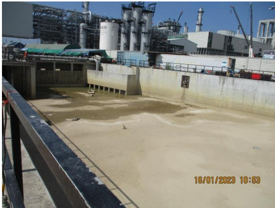
รูปที่ 2-11 ระบบระบายน้ำในพื้นที่ก่อสร้างและเชื่อมต่อกับบ่อรวบรวม
