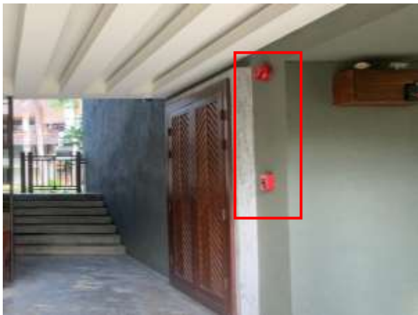
รูปที่ 21 อุปกรณ์ส่งสัญญาณเตือนเกิดอัคคีภัย
