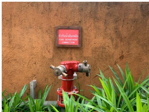
รูปที่ 20 หัวรับน้ำดับเพลิงจากภายนอกโครงการ
