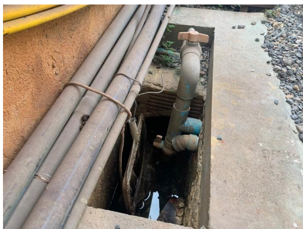
รูปที่ 24. ป่อพักน้ำสุดท้ายก่อนระบายออกสู่ทะเล
