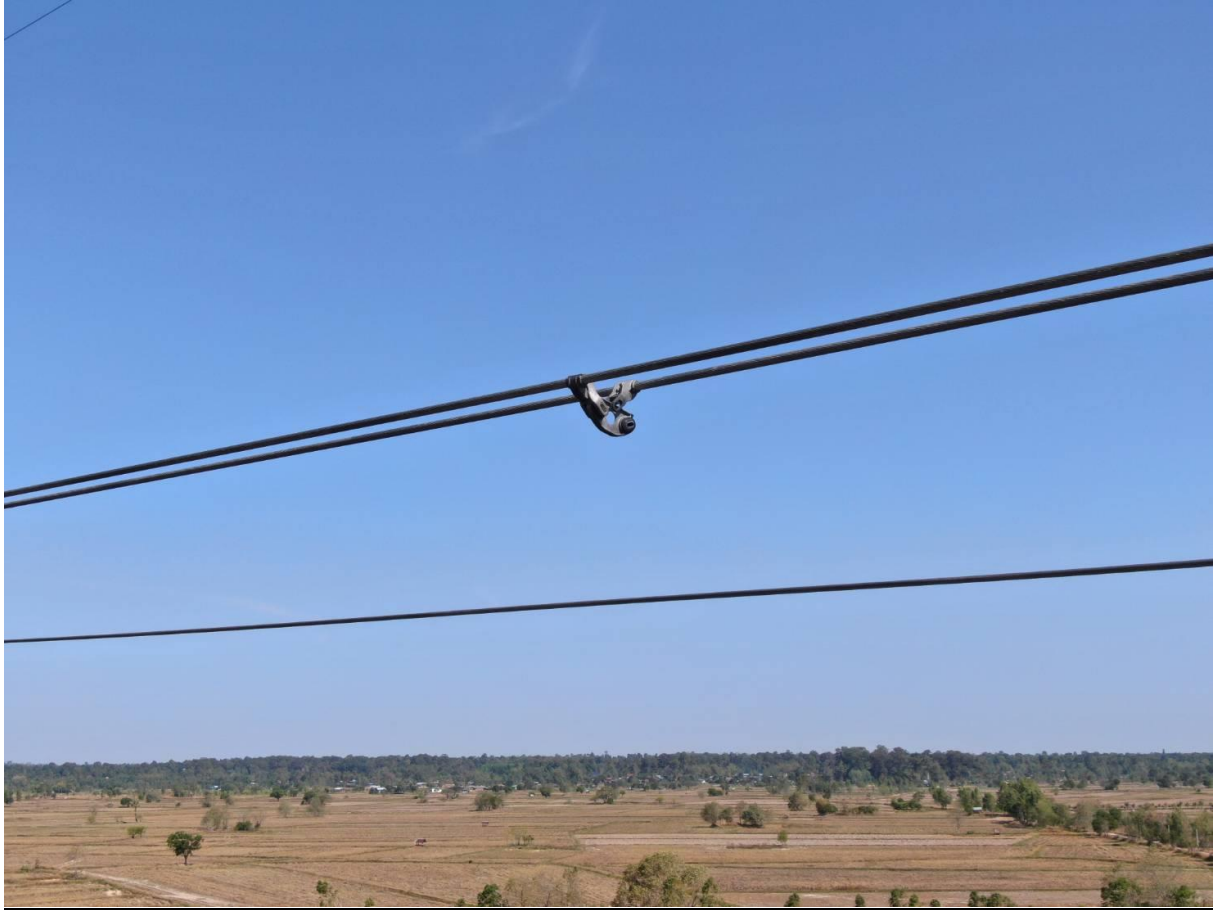
ภาพปฏิบัติงานตรวจ Spacer ขำรุด Line 230kV UB3-YT ขำรุดทั้งหมดจำนวน 5 ตัว
