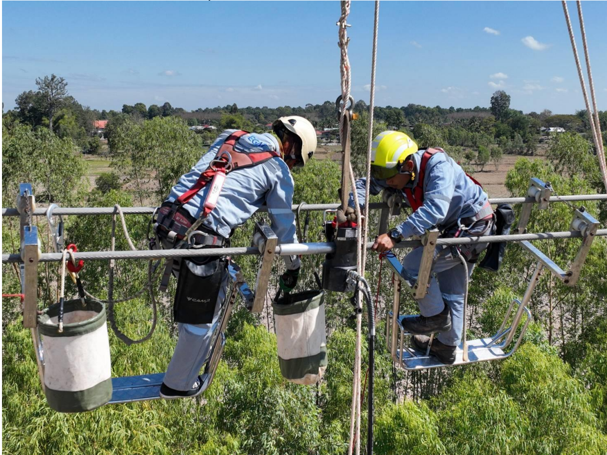
ภาพปฏิบัติงานซ่อมสายแตกจาก Spacer กัดสาย ช่วงเสาต้นที่ 13/2-3 Line 230kV UB3-YT วันที่ 3 กุมภาพันธ์ 2566 โดยวิธีดับไฟ ปีน Sleeve
