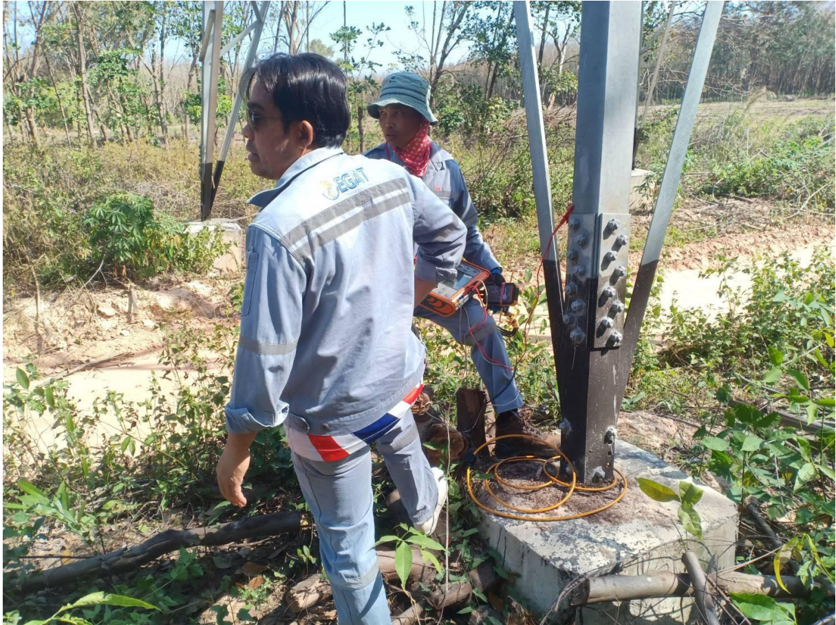
ภาพปฏิบัติงานตรวจสอบสายส่งตามวาระ 5 ปี และประเมินสภาพเสาเสื่อม Line 230kV UB3-YT
