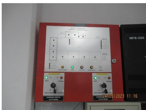
ภาพที่ 2-32 ตู้ควบคุมสัญญาณเตือนต่างๆ
