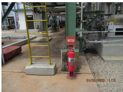
ภาพที่ 2-37 เครื่องดับเพลิงชนิดผง (Powder Extinguisher)
