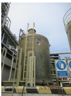
ภาพที่ 2-26 คันคอนกรีตป้องกันการรั่วไหลของสารเคมี
