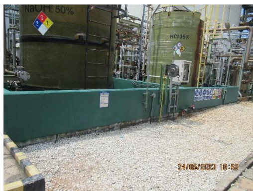
ภาพที่ 2-26 คันคอนกรีตป้องกันการรั่วไหลของสารเคมี
