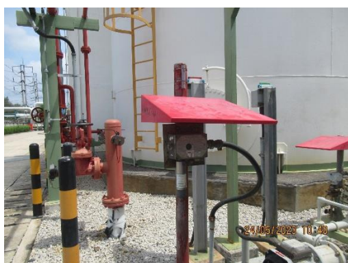
ภาพที่ 2-31 Gas Detector และ Ammonia Detector
