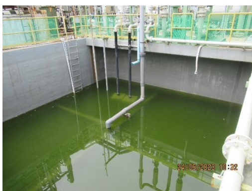
ภาพที่ 2-5 ถังปรับสภาพ (Neutralization Basin)
