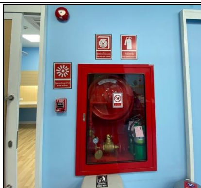
อุปกรณ์ส่งเสียงสัญญาณแจ้งเหตุเพลิงไหม้ (Fire Alarm Manual Station)
