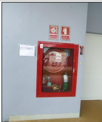
เก็บสายฉีดน้ำดับเพลิงพร้อมอุปกรณ์ (Fire Hose Cabinet: FHC)
