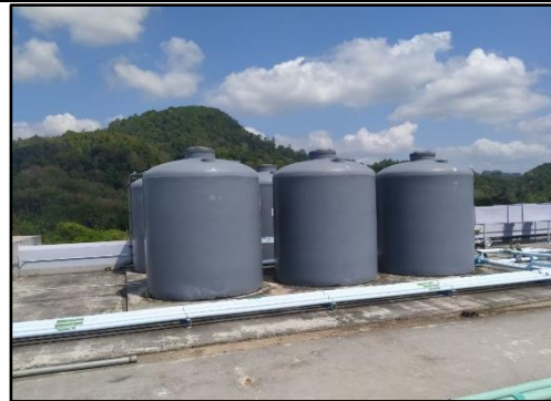
ถังเก็บน้ำใช้บ่ออาคาร จำนวน 6 ถัง
