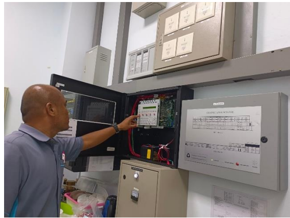
รูปที่ 3-23 ตรวจสอบอุปกรณ์แจ้งเหตุเพลิงไหม้
