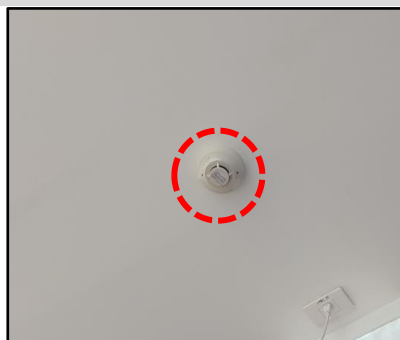
เครื่องตรวจจับควัน (Smoke Detector)
