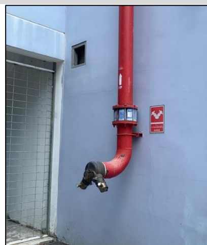
หัวรับน้ำดับเพลิง ขนาด FDC.4"X | 2 1/2"X | 2 1/2" นิ้ว พร้อม Check Valve หัวสวมเร็วและฝาปิด
