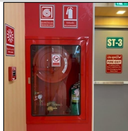
เก็บสายฉีดน้ำดับเพลิงพร้อมอุปกรณ์ (Fire Hose Cabinet: FHC)
