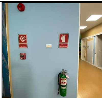
อุปกรณ์ส่งเสียงสัญญาณแจ้งเหตุเพลิงไหม้ (Fire Alarm Manual Station)
