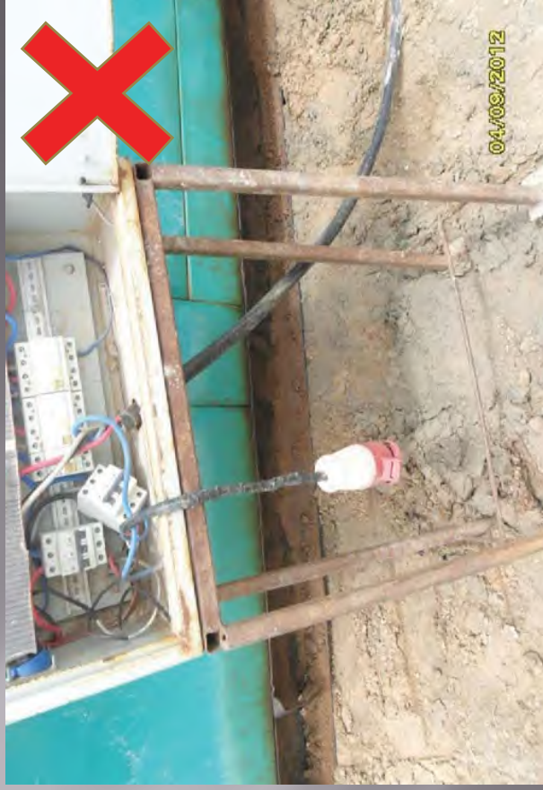
ตู้ไฟ Panel ที่ไม่ได้มาตรฐานถูกนำมาใช้งาน
