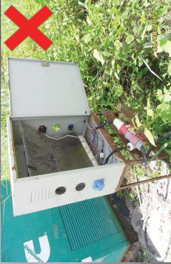
ตู้ไฟ Panel ที่ไม่ได้มาตรฐานถูกนำมาใช้งาน
