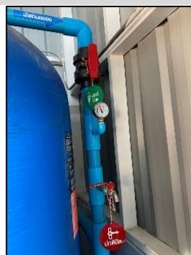
ป้ายแนะนำตำแหน่งเปิด-ปิดวาล์ว
