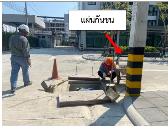
รูปที่ 15 ทำความสะอาดท่อระบายน้ำพื้นที่ โครงการ
