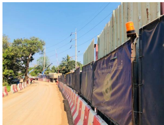
รูปที่ 3.2-28 กำแพงคอนกรีต (Concrete Barrier)
