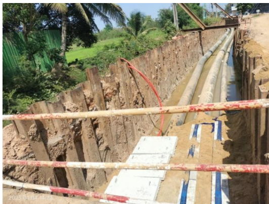
รูปที่ 3.2-26 การติดตั้ง Sheet Pile บริเวณโดยรอบพื้นที่ขุดเปิด
