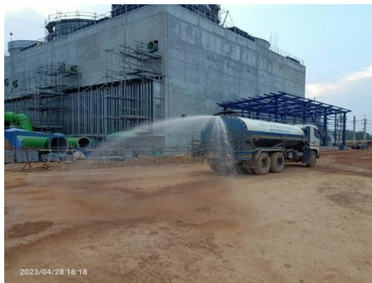
รูปที่ 3.1-5 การฉีดพรมน้ำภายในพื้นที่โครงการ
