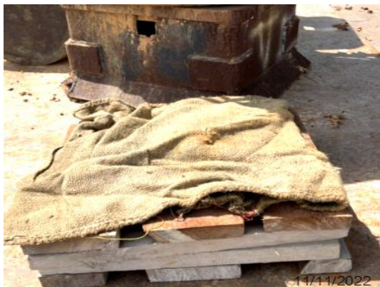
รูปที่ 3.1-14 ไม้หมอนและกระสอบรองหัวเสาเข็ม
