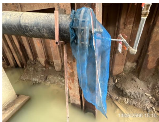
รูปที่ 3.2-25 ตะแกรงคักของแข็งปนเปื้อนบริเวณ ปลายท่อที่ระบายน้ำทิ้งจากการทดสอบท่อ โดยวิธีชลสถิติ
