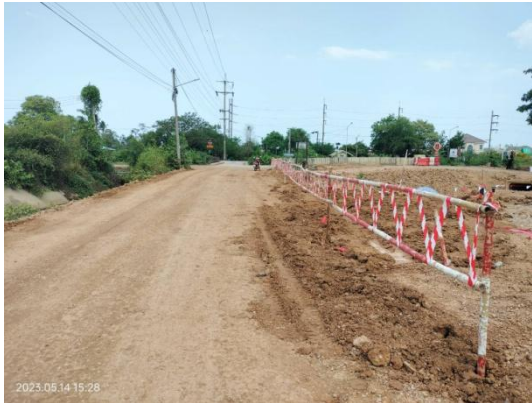
รูปที่ 3.2-1 การฝังกลบเมื่อวางท่อส่งน้ำดิบและท่อน้ำทิ้งแล้วเสร็จ
