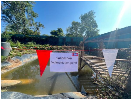
รูปที่ 3.1-28 บ่อตกตะกอนน้ำชั่วคราว ภายในพื้นที่โครงการ
