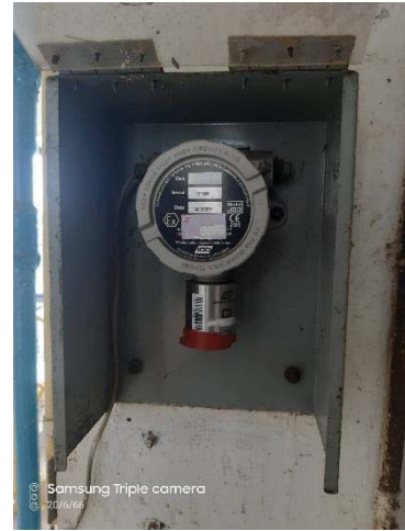
ภาพที่ 19 เครื่องตรวจการรั่วไหล ClO 2
