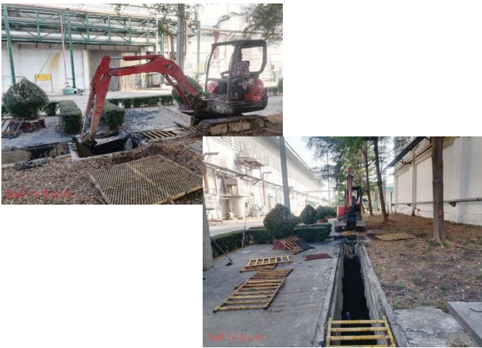
ภาพที่ 8 การขุดลอกร่องระบายน้ำฝน
