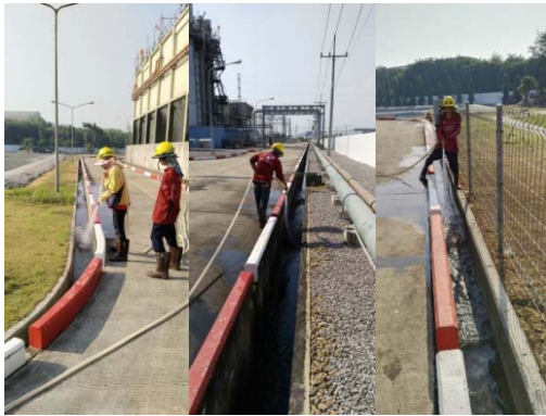
รูปที่ 22 การขุดลอกตะกอนในรางระบายน้ำ
