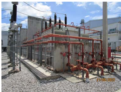
รูปที่ 33 ระบบฉีดพ่นน้ำ
