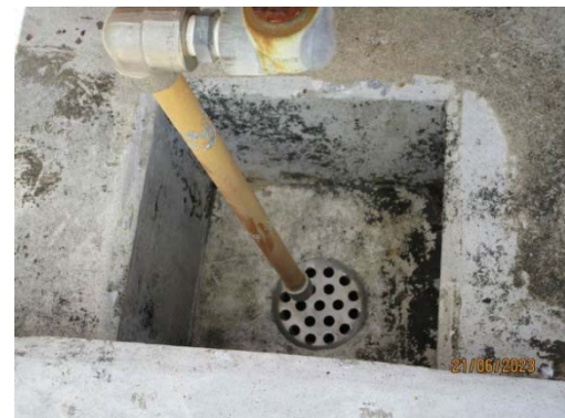
รูปที่ 4 รางระบายน้ำฝนที่ตกในพื้นที่ที่อาจมีการปนเปื้อนของน้ำมัน
