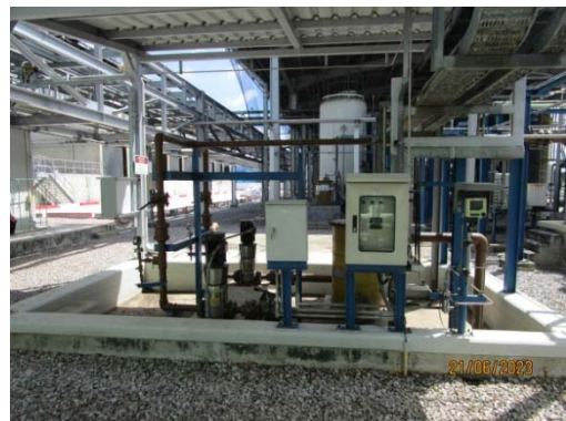
รูปที่ 8 บ่อปรับสภาพน้ำปนเปื้อนสารเคมีด้วยกรด-ด่าง
