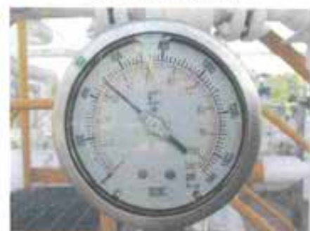
รูปความดันหลังออกจากอุปกรณ์ปรับลดแรงดัน
