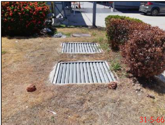
ตะแกรงดักมูลฝอยบริเวณบ่อฟัก ก่อนเข้าสู่บ่อบำบัดน้ำ
