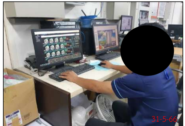
เจ้าหน้าที่คอยตรวจสอบระบบต่างๆ ภายในโครงการ โดยระบบบริหารจัดการอาคาร (Building Management System)
