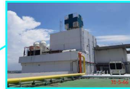
ถังเก็บน้ำบริเวณชั้นดาดฟ้า ความจุ 150 ลบ.ม.
