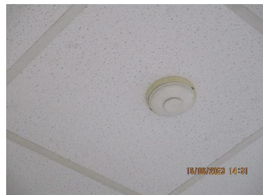
รูปที่ 12 ติดตั้งอุปกรณ์จับควัน และตัวจับความร้อน
