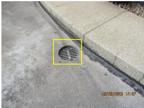
รูปที่ 10 ท่อรวบรวมน้ำฝนจากระเบียงชั้น 3 ของอาคารศูนย์ฝึกอบรม
