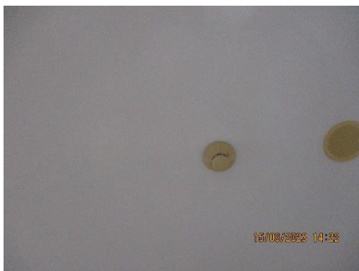
รูปที่ 12 ติดตั้งอุปกรณ์จับควัน และตัวจับความร้อน
