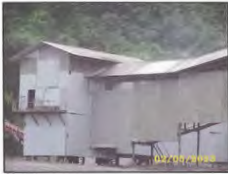
การปิดคลุมโรงโมหินเป็นระบบปิดทั้ง 3 ด้าน
