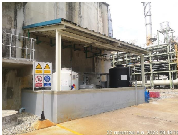
ภาพที่ 2-37 คันคอนกรีตป้องกันการหกรั่วไหลของสารเคมี
