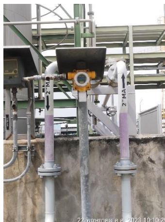
ภาพที่ 2-39 Gas Detector และ Ammonia Detector
