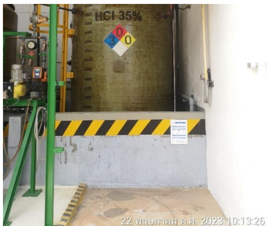
ภาพที่ 2-37 คันคอนกรีตป้องกันการหกรั่วไหลของสารเคมี
