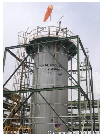
ภาพที่ 2-38 ถังเก็บสารละลายแอมโมเนียมไฮดรอกไซด์เหลว
