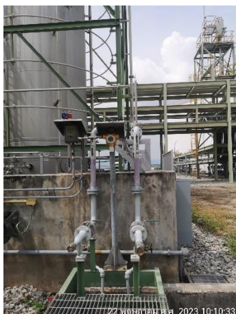
ภาพที่ 2-39 Gas Detector และ Ammonia Detector
