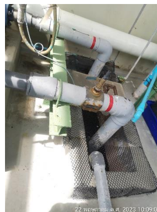
ภาพที่ 2-21 ถังปรับสภาพ (Neutralization Basin) (ได้ดิน)
