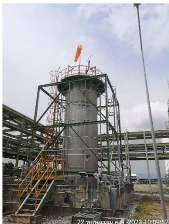
ภาพที่ 2-38 ถังเก็บสารละลายแอมโมเนียมไฮดรอกไซด์เหลว
