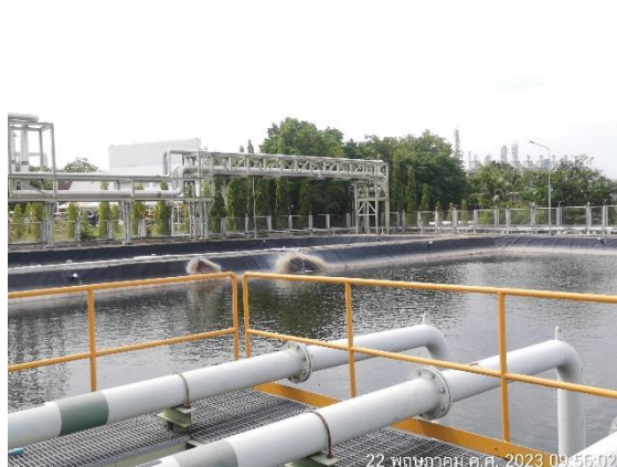
ภาพที่ 2-18 การเดินท่อและติดตั้งปั๊มเพื่อนำน้ำทิ้งจากกระบวนการผลิตมาใช้ใหม่
