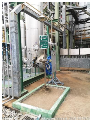
ภาพที่ 2-36 อ่างล้างตาและฝักบัวฉุกเฉิน
