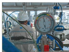
ความดันก๊าซก่อนเข้าสู่อุปกรณ์รับลดแรงดัน
