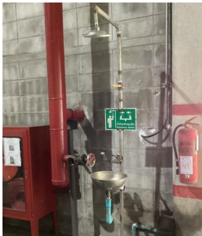
ภาพที่ 29 อ่างล้างตาและร่างกายฉุกเฉิน
