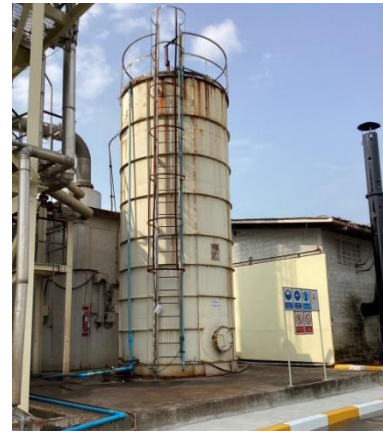
ภาพที่ 8 ถึงเก็บกักน้ำขนาด 75 ลบ.ม.
