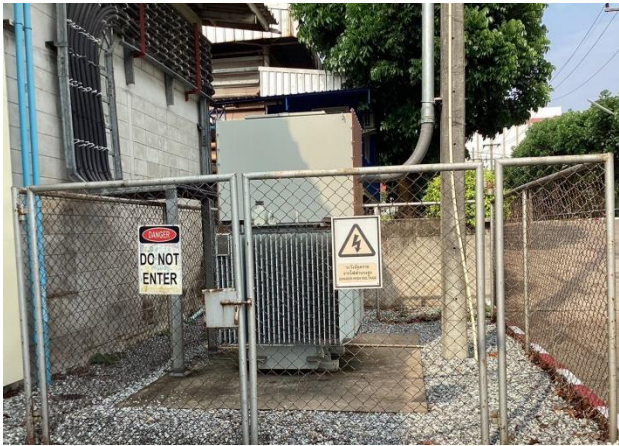
ภาพถ่ายที่ 19 ป้ายเตือนบริเวณหม้อแปลงไฟฟ้า
