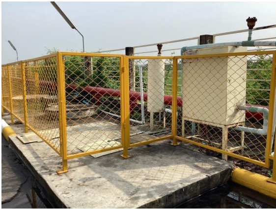
ภาพที่ 7 ถึงพักน้ำเสียก่อนระบายสู่ระบบบำบัด
