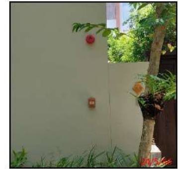
อุปกรณ์ส่งเสียงสัญญาณแจ้งเหตุ
