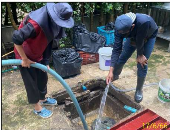
การสูบล้างออกจากช่องแยกกาก และช่องตกตะกอน
