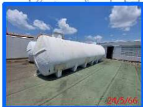
ถังเก็บน้ำขึ้นตลาดฟ้า ขนาดความจุ 150 ลบ.ม.
